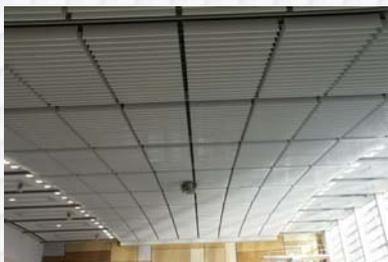
◀ Baffeln mit besonderen Anforderungen, korrosionsschutz und stoßfest für Schwimmbäder...
