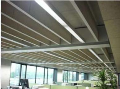
◀ Baffeln aus Heradesign Platten mit Mineralwolle und Einfassprofilen aus eloxiertem Aluminium
