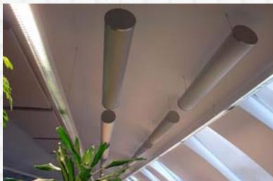
◀ Soundpipes mit Streckmetall, Durchmesser 220 mm, Lieferung mit verschiedenen Maschen möglich ▶
